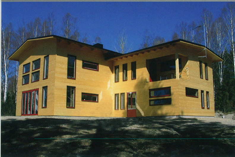
Villa byggd med limträstock.
